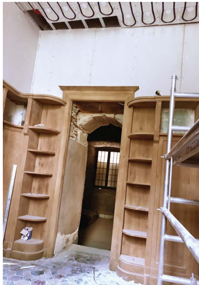
Le rez-de-chaussée a été traité en plancher chauffant/ rafraîchissant, à l'exception de la bibliothèque chauffée par le plafond pour préserver le sol en carrelage.
